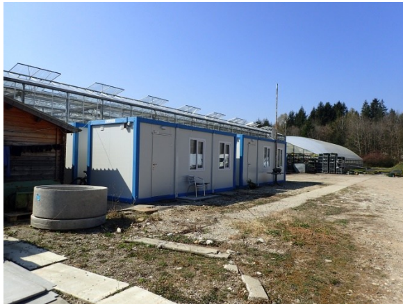
Abb. 4 Fotoaufnahme des Teilbereichs WS-T im März 2020 mit Baustellencontainern
