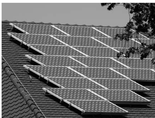
Abb. 9 Unzulässige Anordnung von Solarmodulen, Quelle: Solaranlagen gut gestalten (2013)
