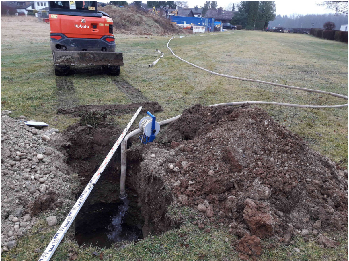
Foto 7: SG 3, Blick nach Südosten
