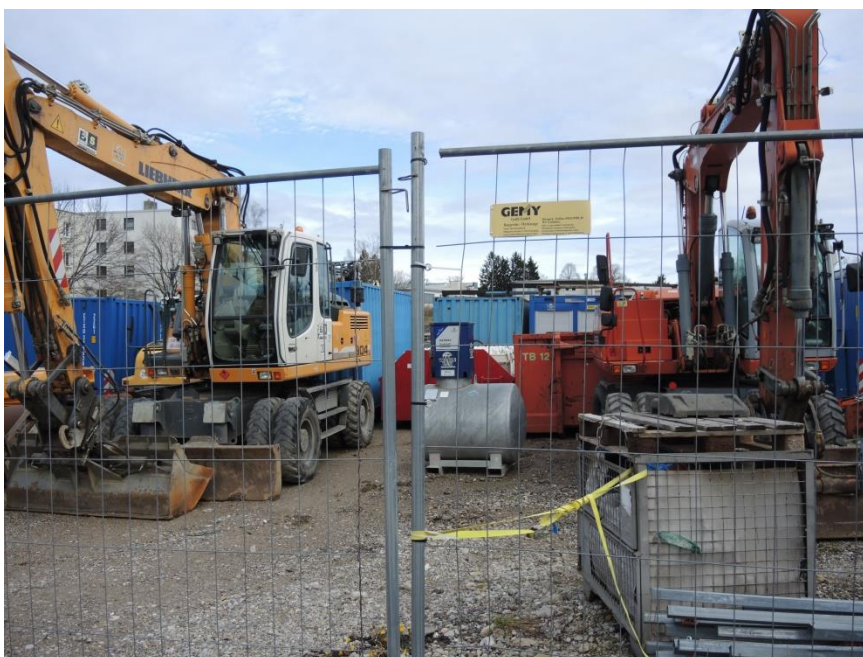
Abb. 7: Blick von Süden auf die Schotterfläche
