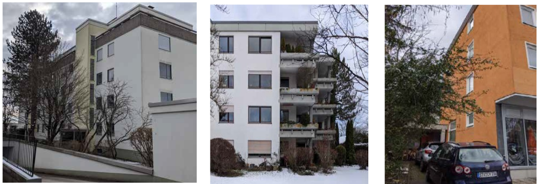
Abb. 3 Bestandsgebäude auf den angrenzenden Grundstücken: Parkstraße 7-9 (links), Parkstraße 3 (Mitte) und Pippinplatz 9 (rechts). Quelle: BHB
