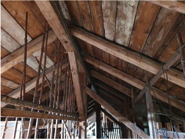
Abb. 5: Blick in Richtung Süden im Dachstuhl; zu erkennen ist die Verschalung
