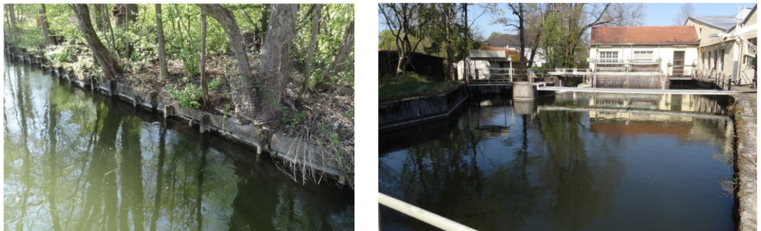
Abb. 2 Würmufer und Wasserkraftwerk, Stand 07.2024
